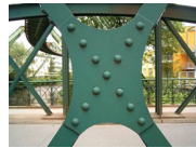
Illustration d'une liaison encastrement
